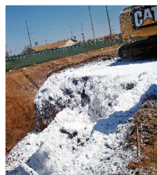
This bio-degradable, non-hazardous foam can be sprayed easily onto soil to minimize odor and control dust. Esta espuma bio-degradable, no peligrosa, puede aplicarse fácilmente sobre la tierra para minimizar el olor y controlar el polvo.
